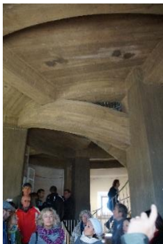
Piloni in cemento collegati verticalmente agli anelli - Scala elicoidale - Scala per l'accesso al terrazzo
