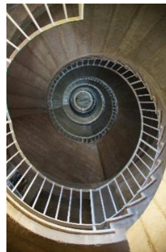
Piloni in cemento collegati verticalmente agli anelli - Scala elicoidale - Scala per l'accesso al terrazzo
