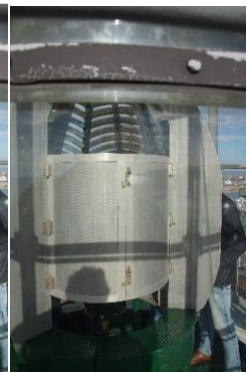
Lenti Fresnel con settore oscurato
