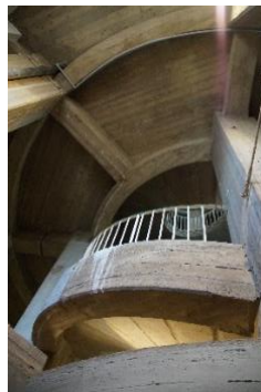
Piloni in cemento collegati verticalmente agli anelli - Scala elicoidale - Scala per l'accesso al terrazzo
